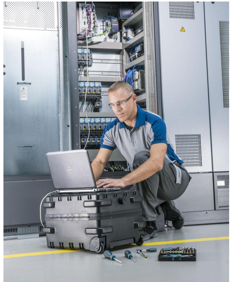
Notre équipe de 60 techniciens terrain dispose d'outils de diagnostic les plus modernes pour redémarrer les équipements dans les meilleurs délais.
