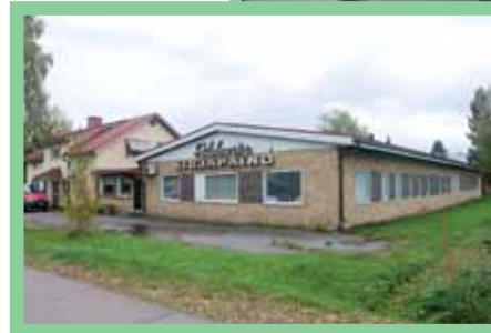
Painotalon koko ei hahmotu kadulta tullejalle ennen kuin näkee rakennuksen todelliset mittasuhteet.
